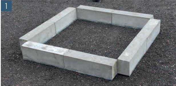
Das Baumquartier gemäß Vorgabe herstellen (s. Einbauzeichnungen für verschiedene Oberflächenbeläge, S. 12) Achtung: hier ist eine vereinfachte Darstellung eines Fundaments abgebildet, keine Einbaulösung!
