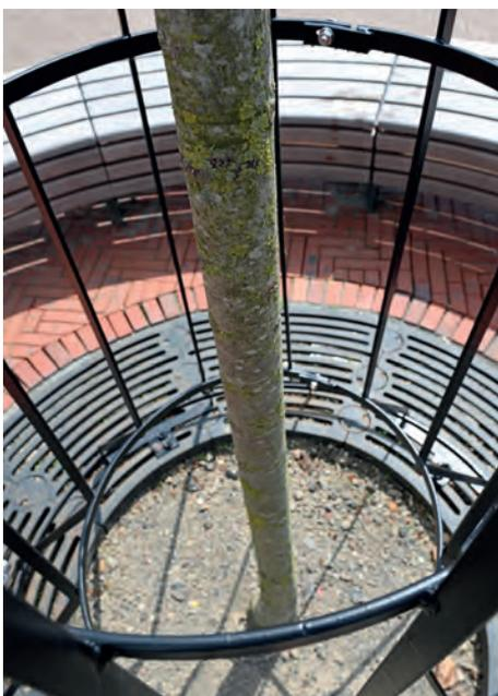
Baumschutzgitter mit mitgelieferten Befestigungshaken auf Baumrost montieren
