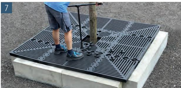
Die Verschlüsse wieder in die Stoßfuge der Baugruppen einsetzen und mit dem in Schritt 4 verwendeten Drehmoment anziehen. Wichtig: Durch das Anziehen der Verschlüsse lässt sich das Fugenbild beeinflussen und korrigieren
