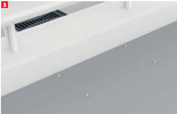
3 Verlegen der Dichtbahn
