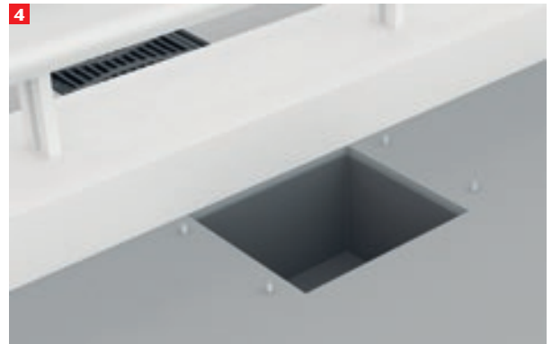
4 Freilegen des Unterteils in der Dichtbahn
