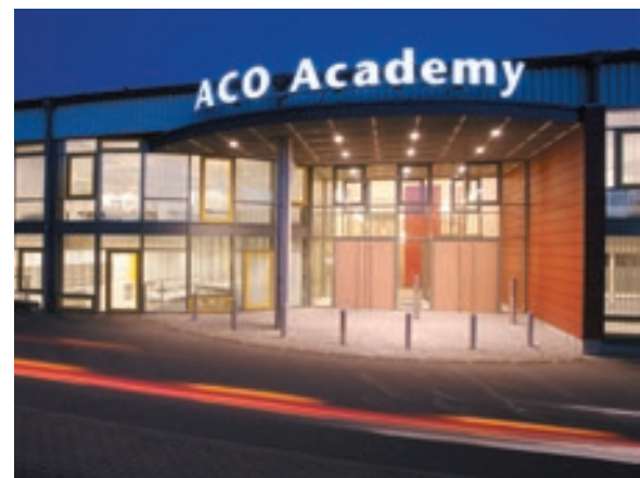
Die ACO Academy in Büdelsdorf/Rendsburg
