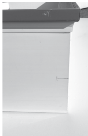
Határozza meg a merevítőprofilok helyzetét és jelölje meg a profil vastagságát (35 mm).
