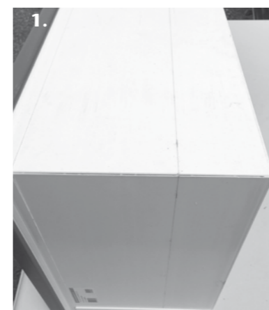
Határozza meg a szükséges teljes magasságot, és jelölje rá a magasítóelemre. A falcsatlakozó U-profil vastagsága 3 mm.
