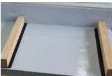
A stafni fákat a vízszigetelésre helyezük. A folyóka felfekvési igénye szerint 50 cm távolságonként.
