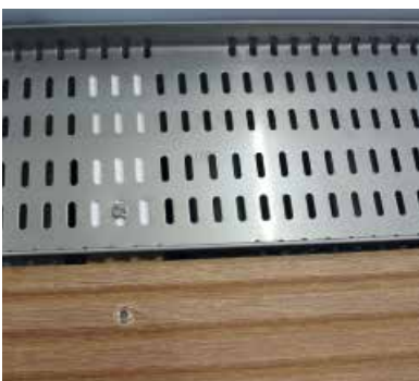
Csavarral rögzítse a folyókatestet a stafnifára a 4 mm szélességű drainnyílások felhasználásával.
