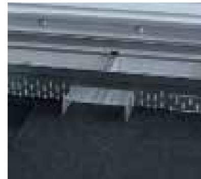
Illessze a csatornákat a túlnyúlással a csatlakozási felülethez
