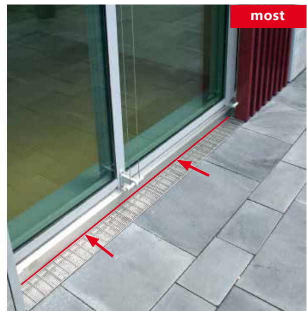
Küszöbfolyóka alkalmazása esetén a folyóka teljesen neki szorítható a homloklathoz
