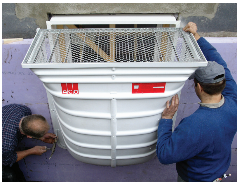
ACO Világítóakna polipropilénből, merevítő bordázattal
