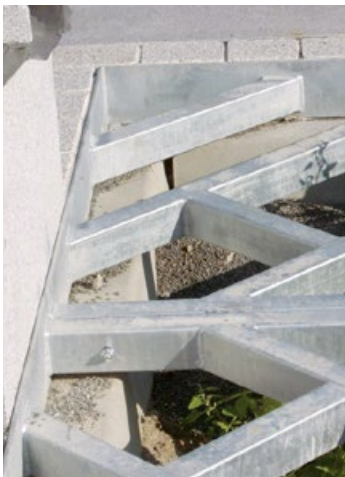
Die Stahlunterkonstruktion sollte auf einem durchgehenden Streifenfundament aufliegen
