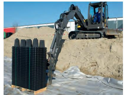
Geringer Platzbedarf durch das optimale Stapeln der Grundelemente sowie das einfache Handling auf der Baustelle verringern die Logistikkosten
