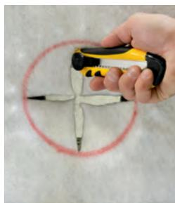
Mit einem Permanentmarker werden die Öffnungen auf dem Geotextil angezeichnet. Anschließend wird die Öffnung mit einem Cuttermesser eingeschnitten.
