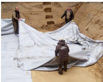
Nach Erstellung des ebenen, stein- und gefällefren Planums wird die Baugrube mit einem Filtervlies ausgelegt
