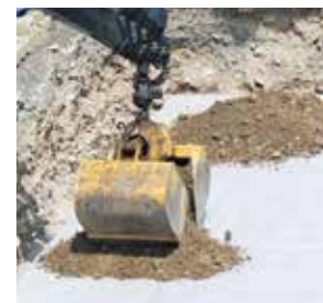
Földfeltöltés a rendszer tetejére
