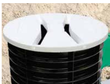
Az ideiglenes műanyag fedő védi a szikkasztó rendszert a behulló szennyeződéssel szemben a kivitelezés ideje alatt.
