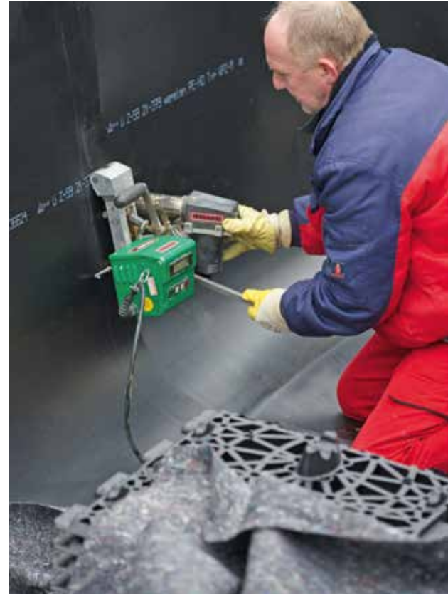
A vízzáró fólia hegesztett technológiával készül
