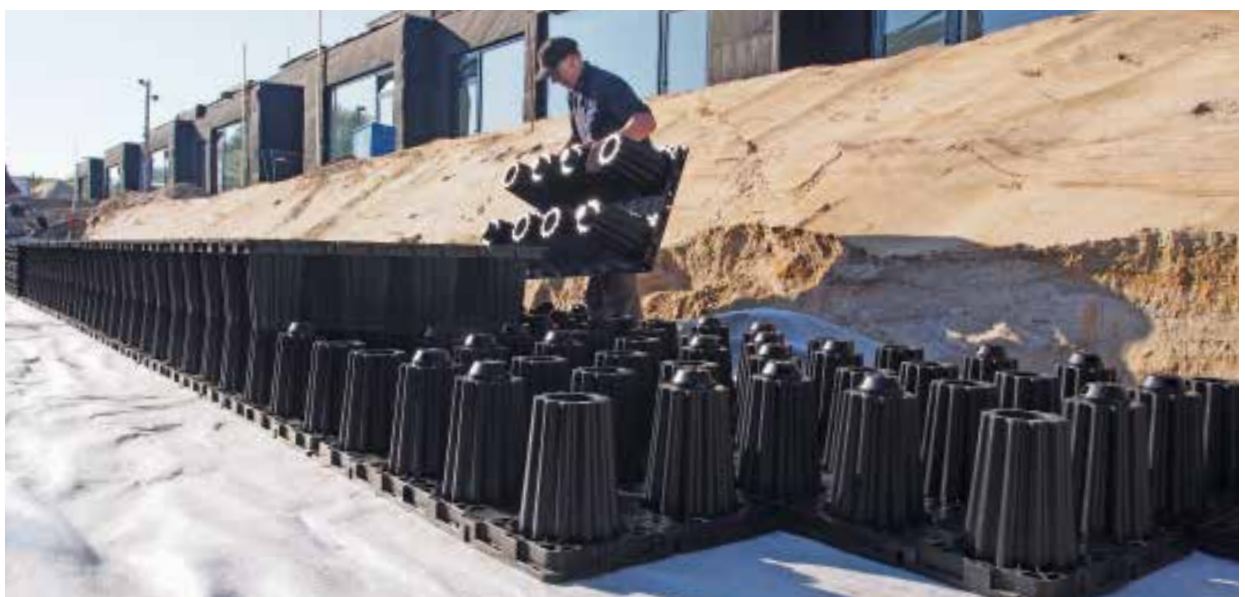
A rendszer félelemek (alapelem) összepattintásával alakítható ki
