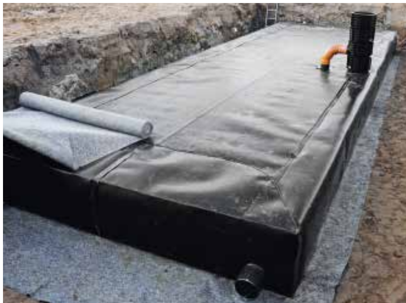
A vízzáró fólia hegesztését követően geotextiliával fedjük a teljes rendszert
