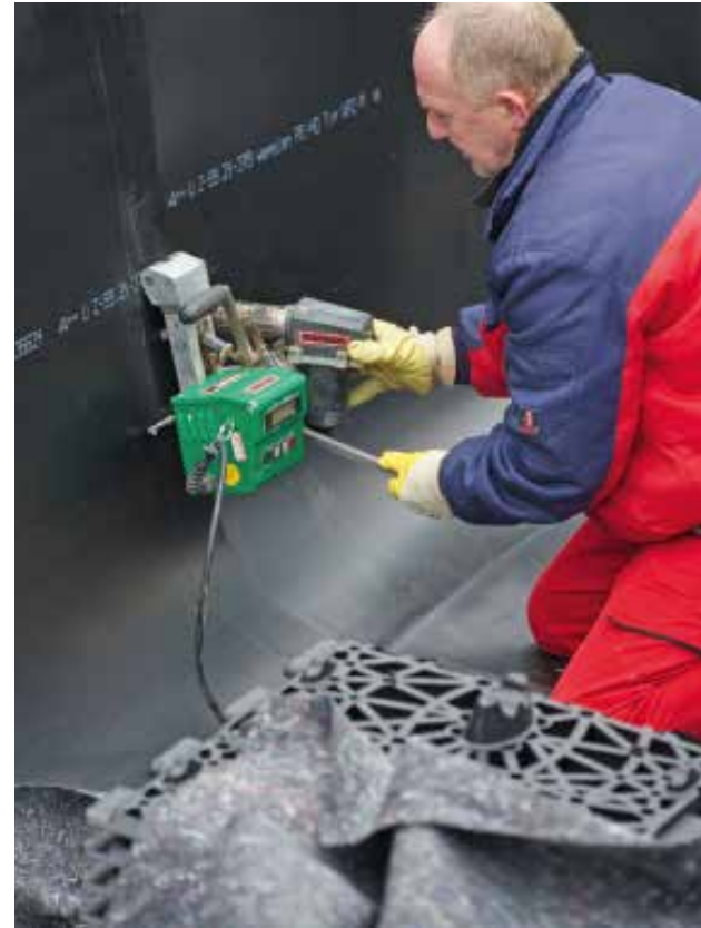
A vízzáró fólia hegesztett technológiával készül
