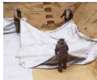
A teljesen sík és kőmentes felület kialakítását követően leterítjük a geotextiliát.
