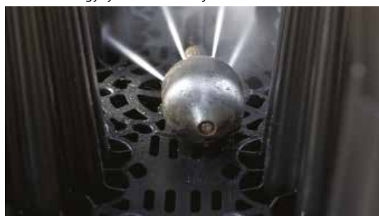
Kamera és nagynyomású mosófej bevezetése
