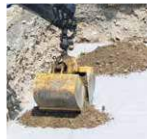
Földfeltöltés a rendszer tetejére
