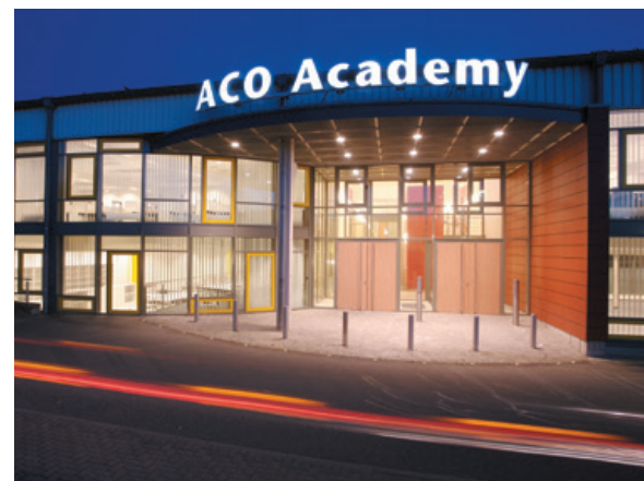
Die ACO Academy in Büdelsdorf/Rendsburg
