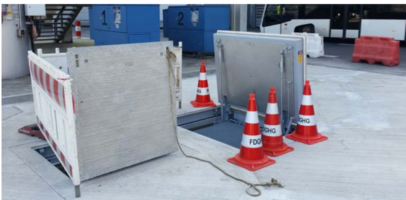
Zugangs- und Montageöffnungen, F900, Düsseldorf
