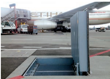
Schwerlastabdeckung, Belastungsklasse F900, Genf
