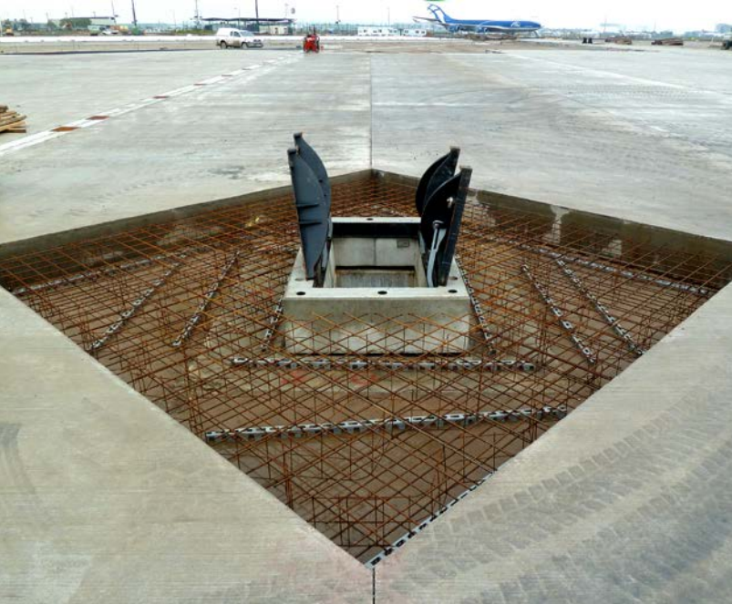
Kabelschachtabdeckung mit Dreiecksdeckeln als Fertigteil mit höhenverstellbarem Stahlbetonrahmen, Belastungsklasse F900, Frankfurt
