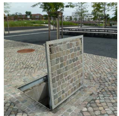
Abdeckung mit aufplasterbarer Oberfläche, Landau
