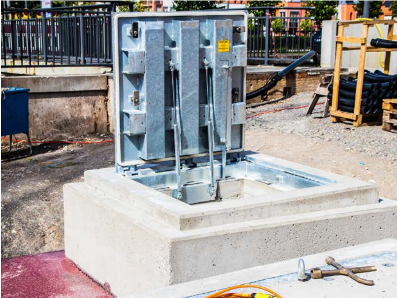
Manuell betätigte, rückstausichere Abdeckung, D400 mit Öffnungshilfe
