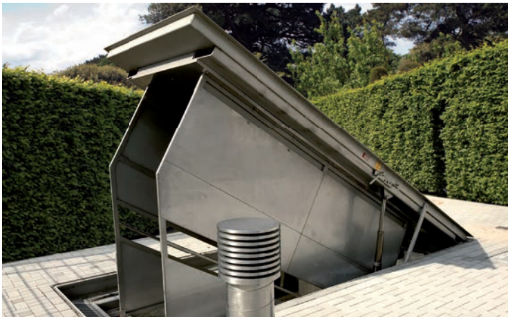
Einstieg in Pumpwerk, Seligenstadt
