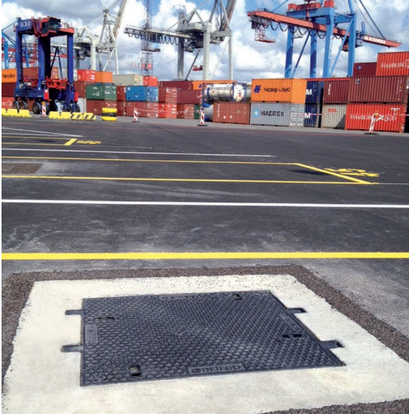
Gussabdeckung mit Dreiecksdeckeln und Fertigteilrahmen, F900, Hamburg
