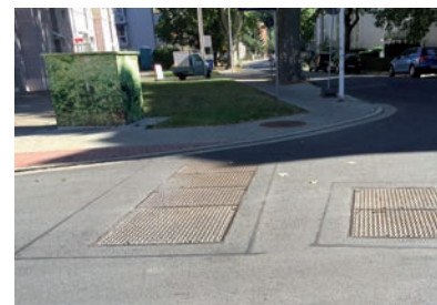
Reihengussabdeckung als Modulabdeckung Belastungsklasse D400, Dresden
