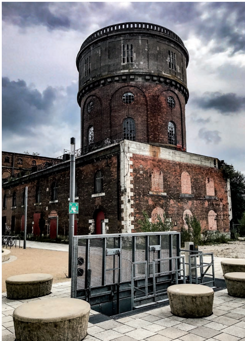
Notausstieg mit hydraulischem Antrieb als Gitterrost, Ingolstadt
