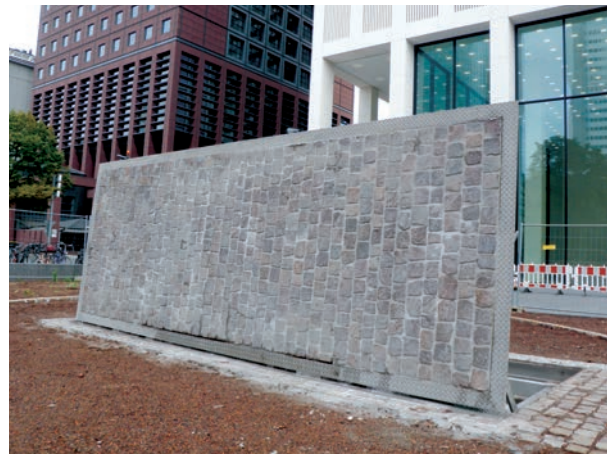
Notausstieg mit ausgepflastertem Deckel, Frankfurt
