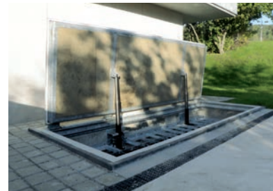
Hydraulische Abdeckung auf Holzhackschnitzelbunker mit Brandschutzklasse F90, Eisenstadt/Österreich
