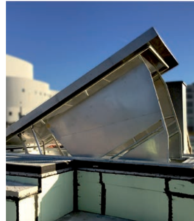
Hydraulisch betätigte Notausstiegabdeckung, Düsseldorf
