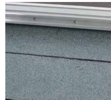
Bitumenes szigetelés kialakítása
