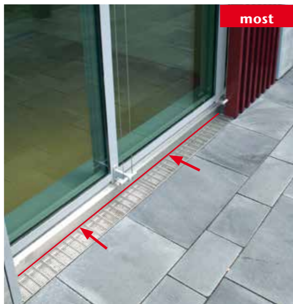
Küszöbfolyóka alkalmazása esetén a folyóka teljesen neki szorítható a homloklapnak
