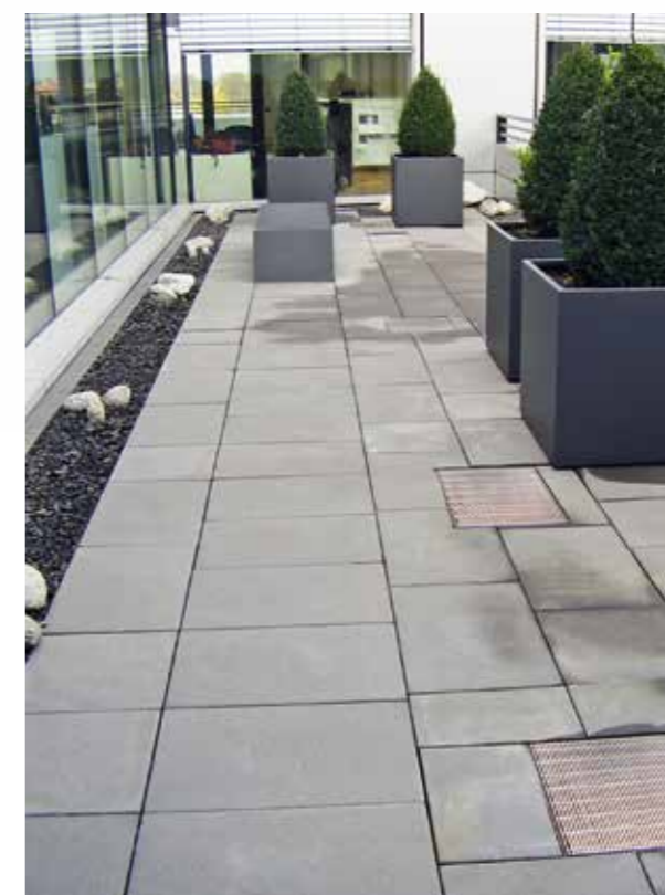
ACO Profiline rejtettcsatorna-átkötés a burkolat alatt
