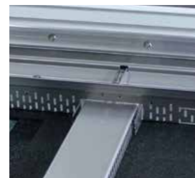
A rejtettcsatorna beillesztése a folyókába.
