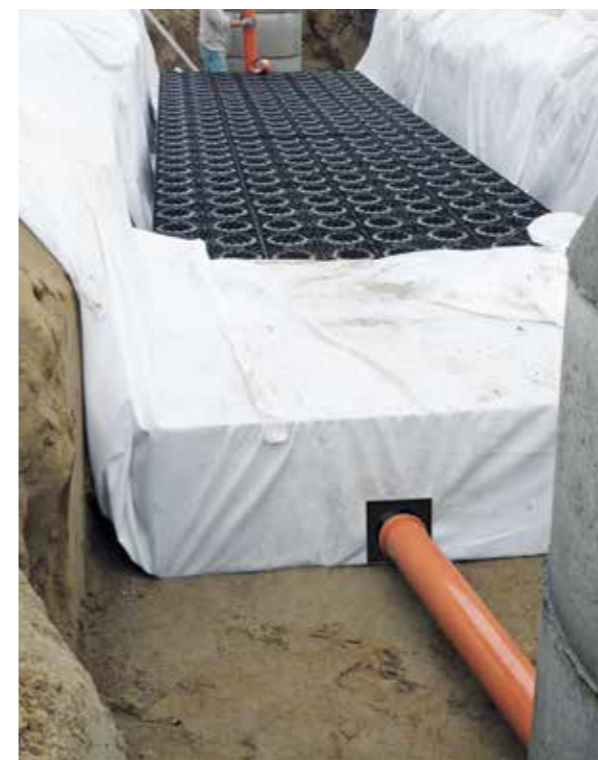
A geotextília teljesen körbeburkolja a szikkasztórendszert
