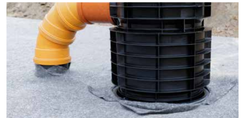
Szellőzőcső csatlakozása a nyaktaghoz.
