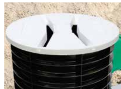
Az ideiglenes műanyag fedő védi a szikkasztórendszert a behulló szennyeződéssel szemben a kivitelezés ideje alatt.
