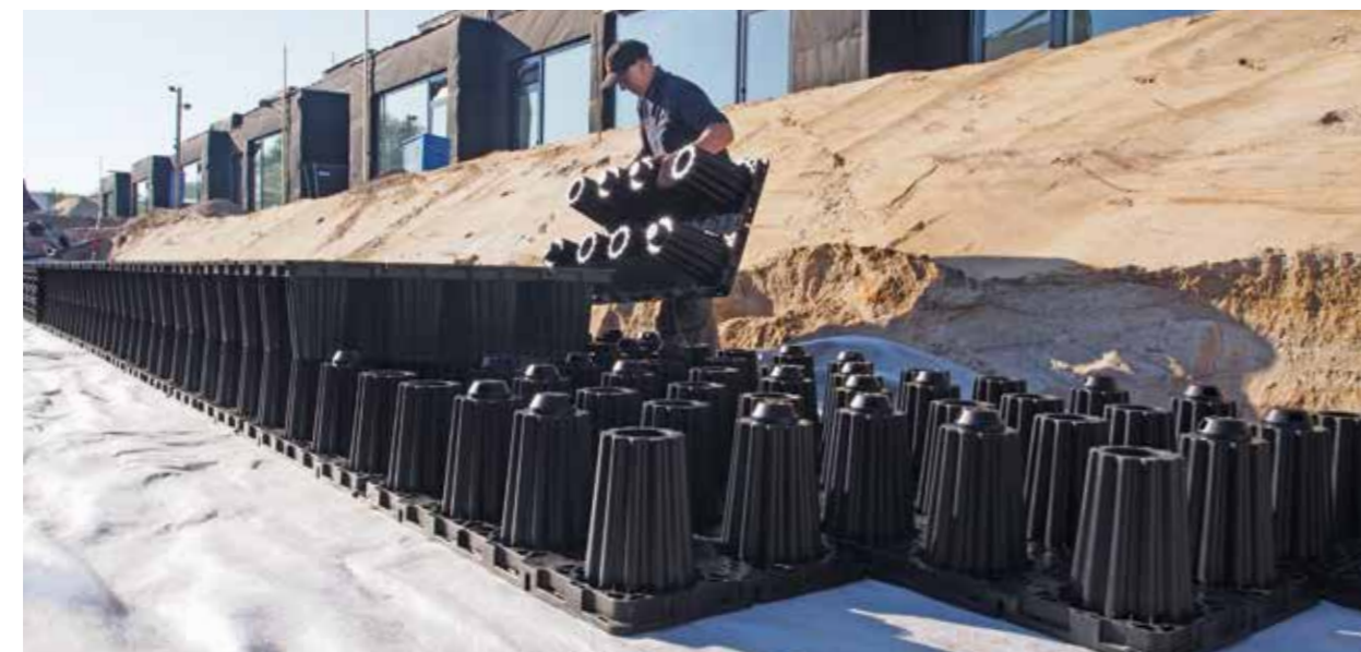
A rendszer félelemek (alapelem) összepattintásával alakítható ki
