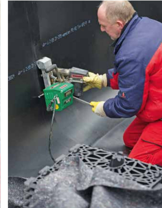
A vízzáró fólia hegesztett technológiával készül
