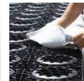
A geotextília teljesen körbeburkolja a szikkasztórendszert
