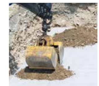
Földfeltöltés a rendszer tetejére
