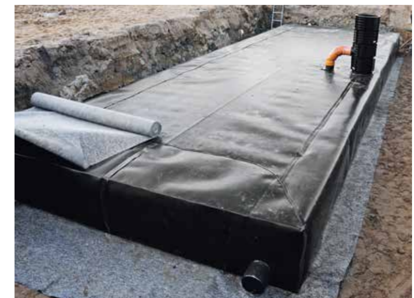
A vízzáró fólia hegesztését követően geotextíliával fedjük a teljes rendszert
