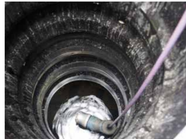
A megfigyelőrendszer és tisztítóegység egyszerűen és akadálymentesen vezethető a rendszerbe a fedlapon keresztül
