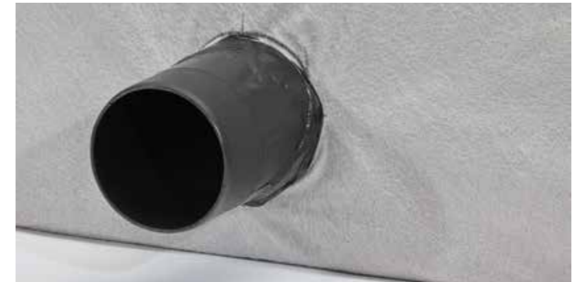
A geotextília rögzítése a csőcsatlakozáshoz
