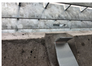
Helyezze be a négy rácskiemelés elleni védőlemezt a rácson kialakított négy hosszúkás lyukba (kettő mindkét oldalon).
