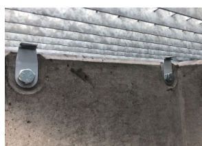
Csavarral rögzítse az angolakna testhez.
