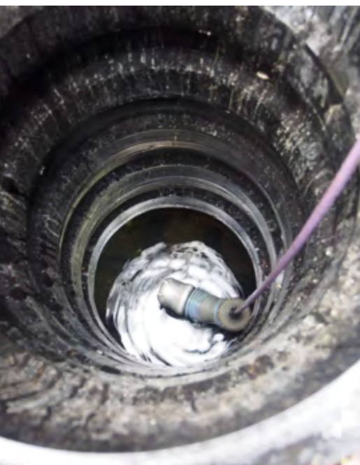
Vertikaler Zugang direkt über der Rigole
