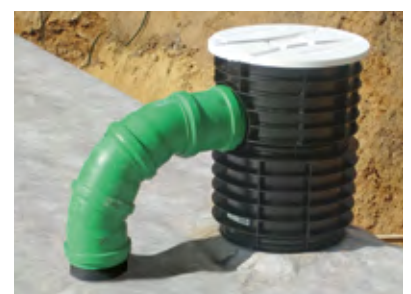
Erstellen einer Be- und Entlüftung: Ein Rohrbogen verbindet Oberteil mit Stützen und Rohrschlussadapter
