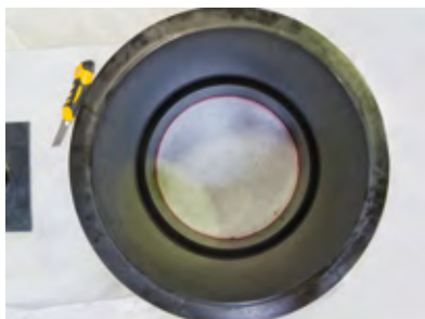
Anzeichnen des Innendurchmessers
