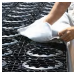
Abschließend wird das schützende Geotextil um die Rigole gelegt, sodass sie vollständig umhüllt ist
