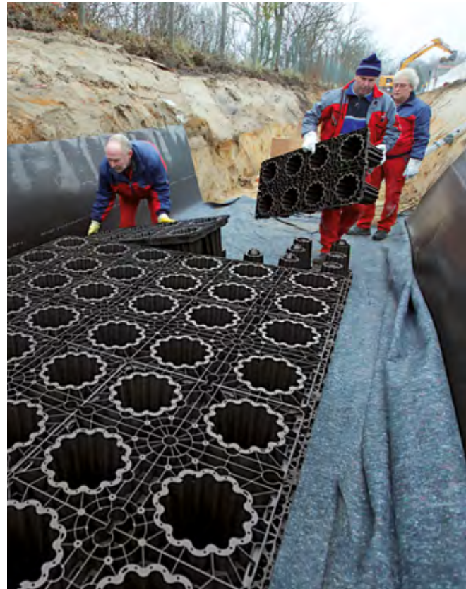
Kurze Wege zur Palette erhöhen das Verlegetempo
