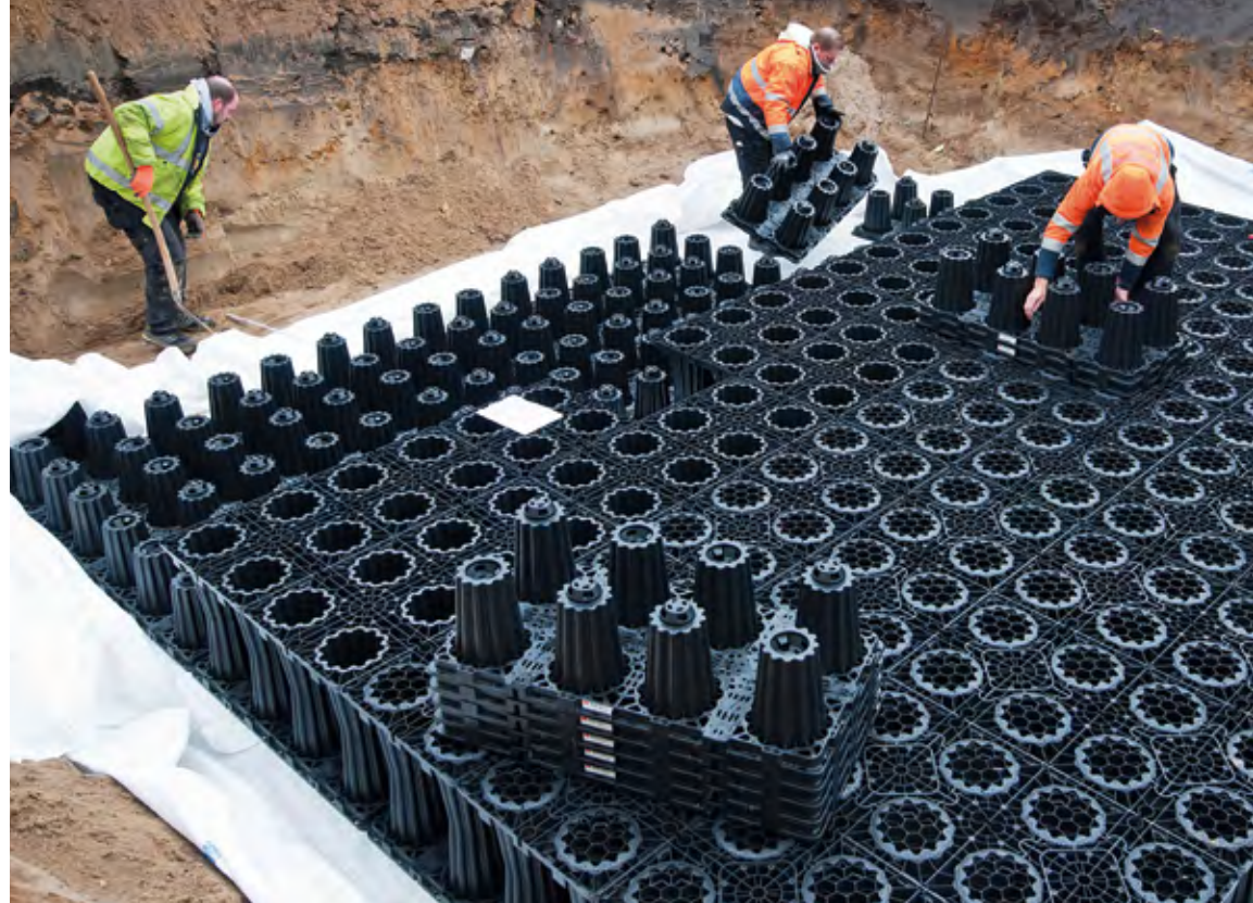
Zu jedem Bauvorhaben erstellt die ACO Anwendungstechnik einen entsprechenden Verlegeplan. Referenz Heider Marktpassage, Heide: ACO Stormbrixx HD als Versickerungsrigole unterhalb von Pkw-Stellflächen.
