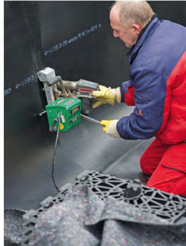
Abschließend wird die Abdichtungsbahn verschweißt
