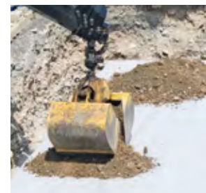
Verfüllen der Rigole
