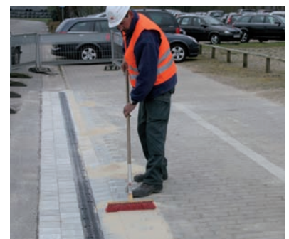
8. Verfüllen der Fugen mit Quarzsand
