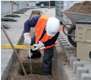
1. Auskoffern für die Verlegung eines V 75 P-Rinnenstranges. Maße entsprechend der benötigten Bauhöhe nehmen
