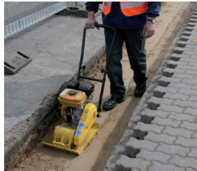
2. Einbringen der Sauberkeitsschicht Verdichten der Sauberkeitsschicht
