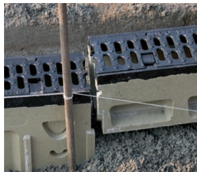
5. Anschließen der Rinnenelemente über Nut-Feder-System an den Einlaufkasten
