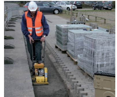
3. Einbringen des Fundamentes Verdichten des Fundamentes
