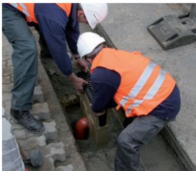
4. Anschließen des Stützens an den Einlaufkasten. Einsetzen und Anschließen des Einlaufkastens an die Grundleitung
