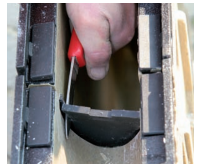
6. Ausschneiden der Anschlusschablone des Einlaufkastens
