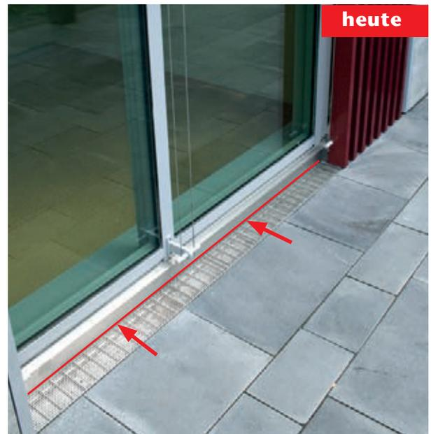
Mit der ACO Keilrinne passgenau vor Fassaden- oder Türanschluss ohne zusätzlichen Kiesstreifen
