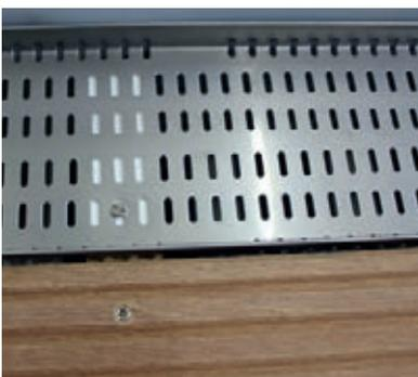
Verschraubung des Rinnenkörpers durch die 4 mm Drainslitze im Rinnenboden
