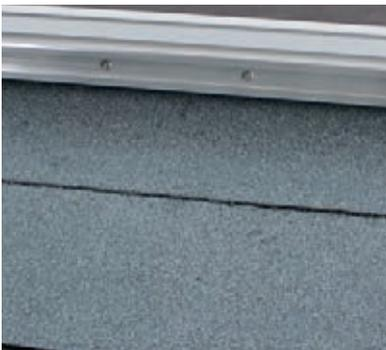
Anschluss einer bituminösen Abdichtung mit Keilbildung
