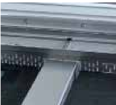
A rejtettcsatorna beillesztése a folyókába.
