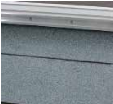
Bitumenes szigetelés kialakítása
