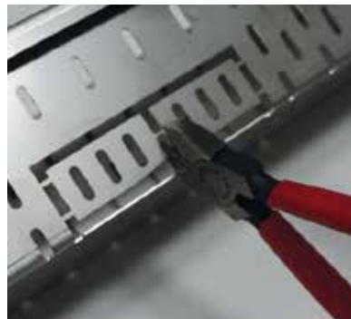
Rejtettcsatorna csatlakozás kinyitása
