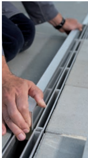
Montage der LED Elemente in den Schlitzrahmen
