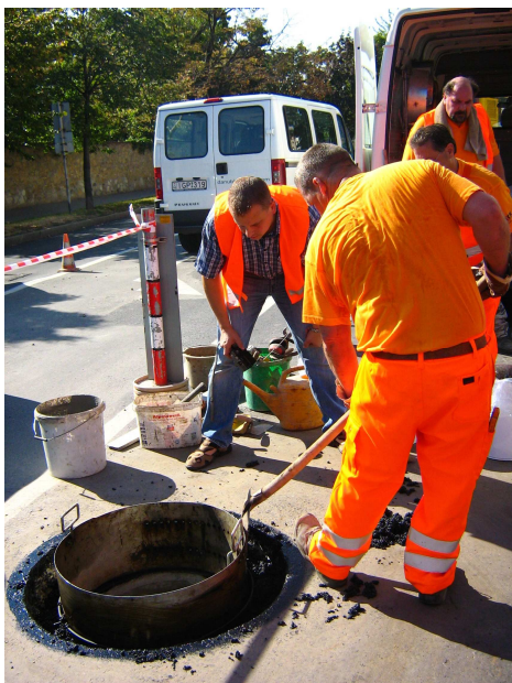
Aszfalt bedolgozása a munkagödörbe.
