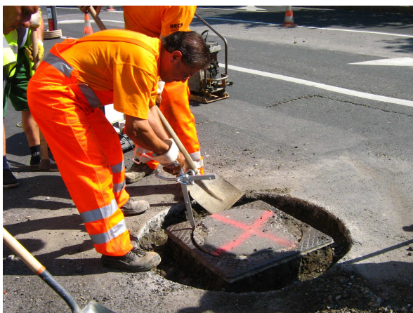
Az elhasználódott fedlap kiemelése.
