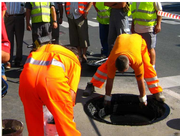
Bent maradó adaptergyűrű elhelyezése
