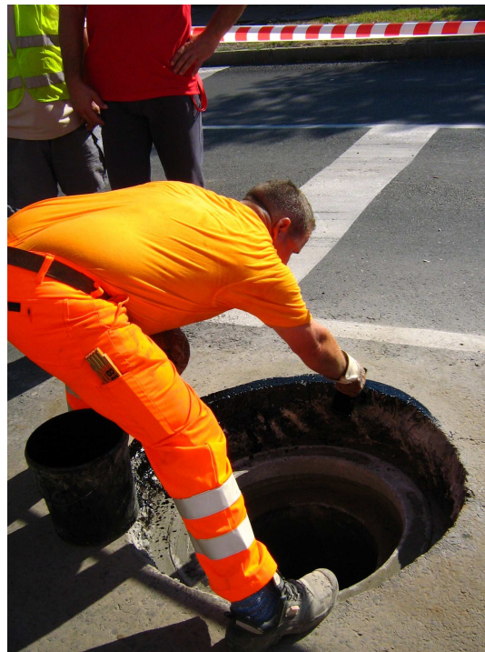
Az aszfalttal érintkező felületek kellősítése fokozott igényességet kíván..
