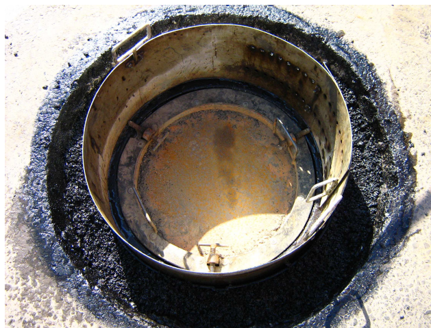
A bedolgozott aszfalt tömörítés előtt.
