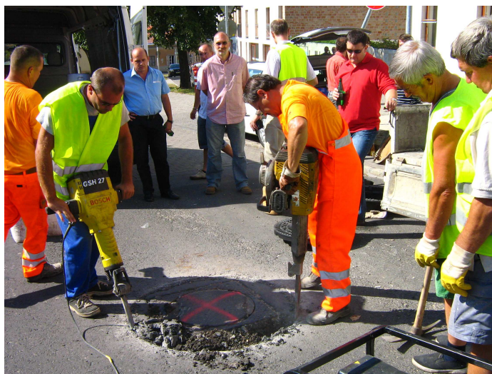
Az elhasználódott fedlap kibontása. Látható, hogy nincs szükség több négyzetméteres felület megbontására, csak a fedlap közvetlen 15-20 cm környezetét kell megbontani.
