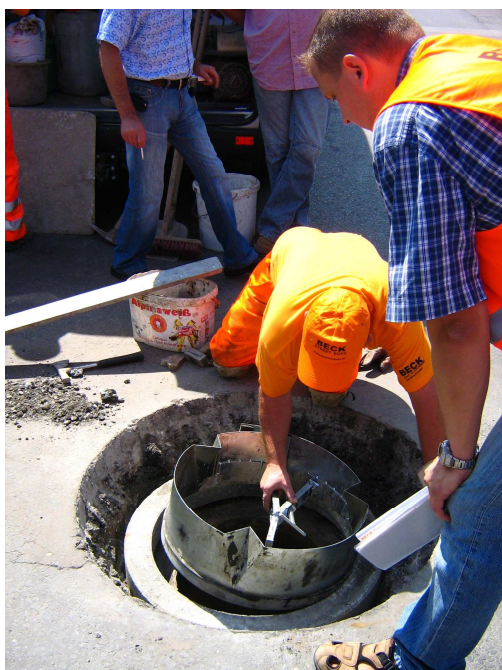
A szintező betongyűrű rögzítése speciális gyorskötő habarccsal történik.
