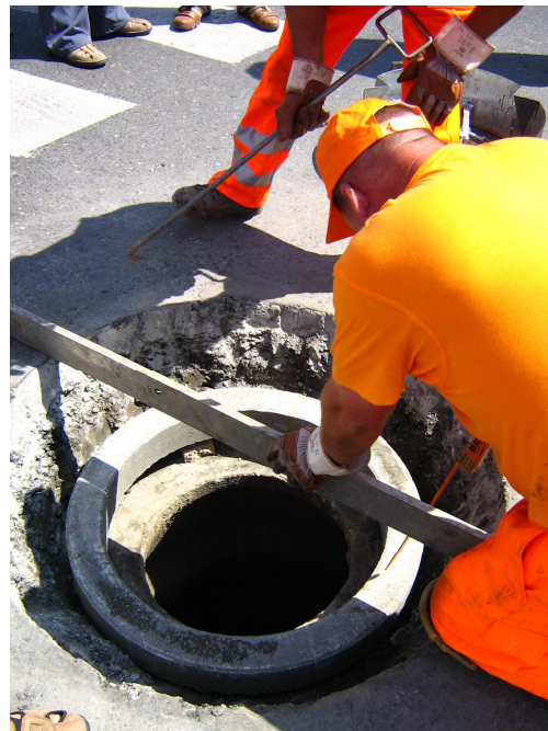
A beépítéshez szükséges szint beállítása betongyűrűvel történik.
