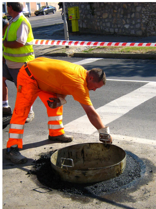
Tömörítést követően a szükséges mennyiségű aszfalt behelyezése következik.
