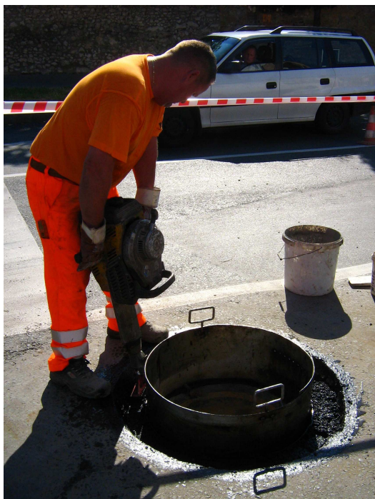
Az aszfalt tömörítése.
