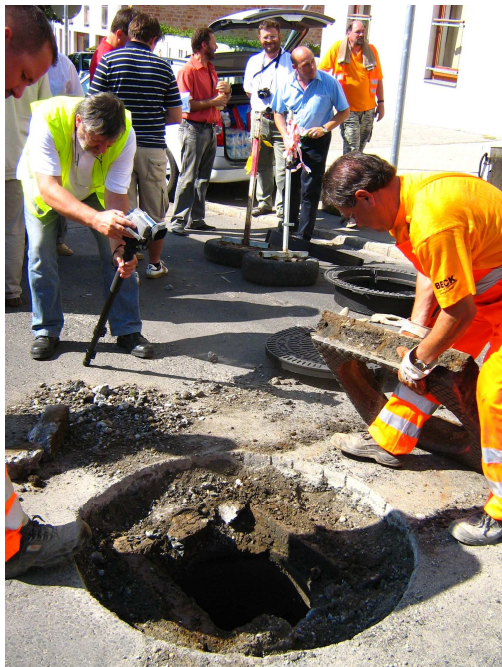
Az elhasználódott fedlap kiemelését követően akna szűkítőig kitisztítjuk a munkagödört..
