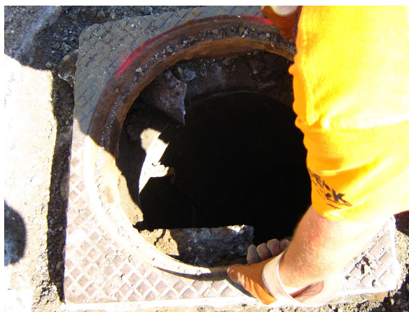
Jól látható a fedlap és az akna közötti összetöredezett habarcs, mely a fedlapok megsüllyedését eredményezi.
