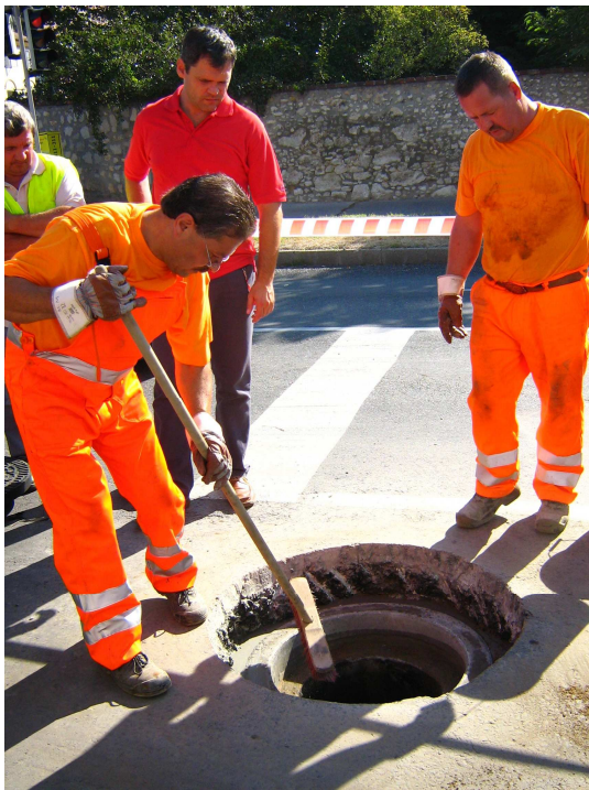
A szintező betongyűrű rögzítése után megtisztítjuk a felületet.
