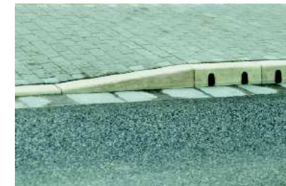
ACO DRAIN® KerbDrain süllyesztett szegélykő kocsibeállókhöz és gyalogos átkelőkhöz
