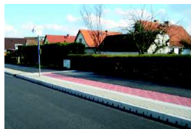
ACO DRAIN® KerbDrain mint buszöböl víztelenítés
