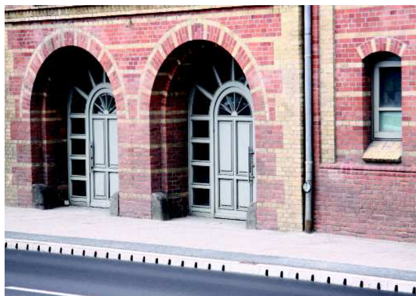
Klasszikus belvárosi útvíz-telenítési megoldás
